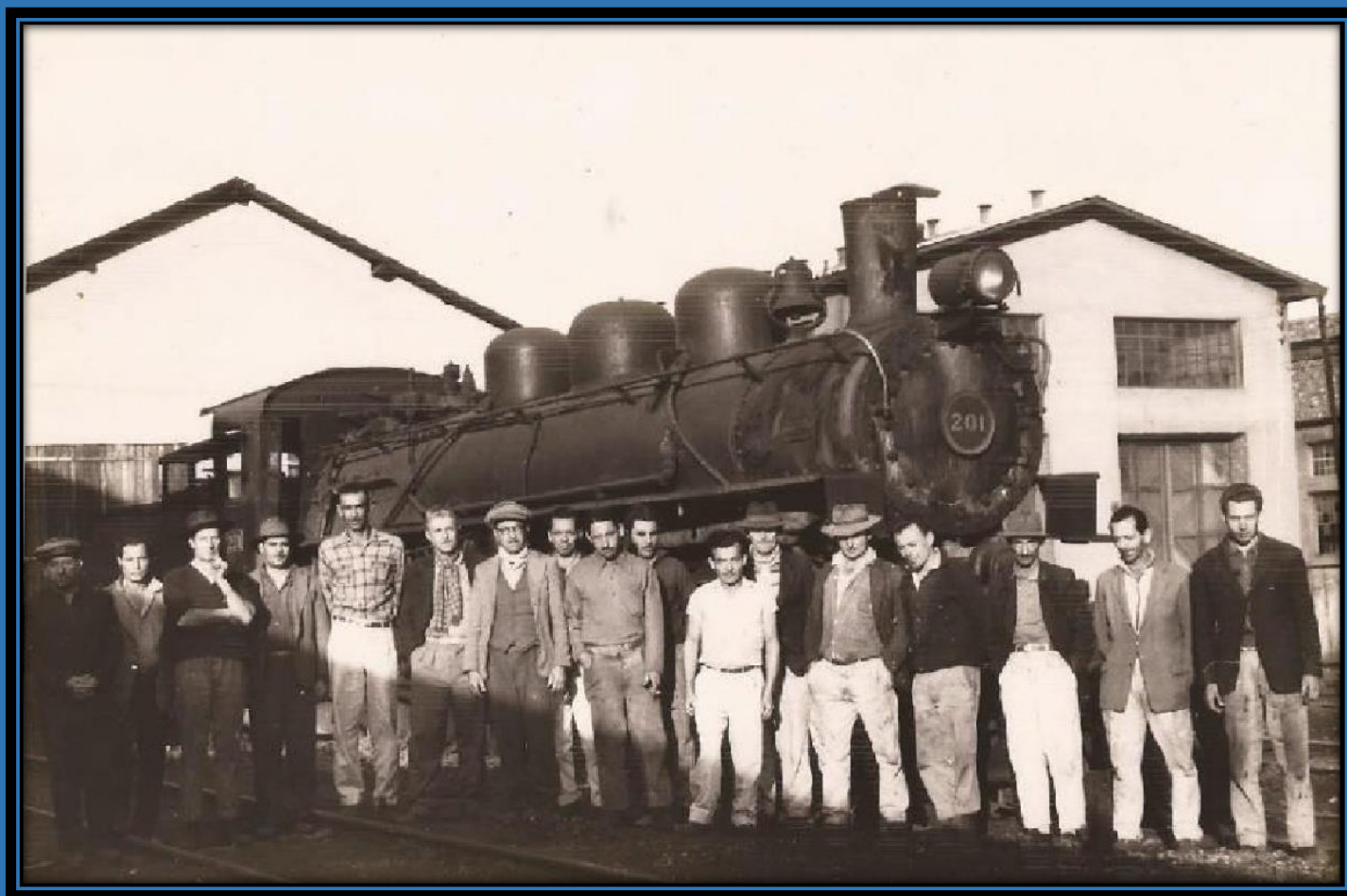
Ferramenta e grupo de trabalhadores da Estrada de Ferro Dona Tereza. Acervo Museu Ferroviário de Tubarão.
